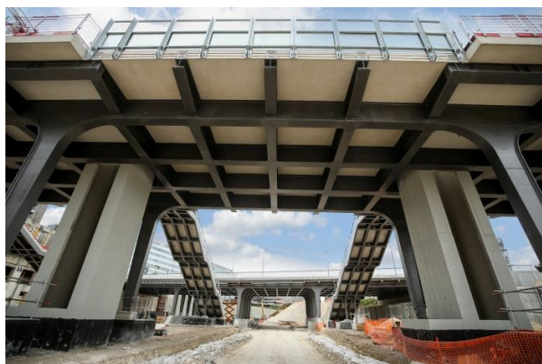
©SNCF Réseau/Projet Eole
