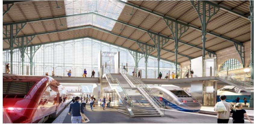
Vue «rapprochée» de la 2 ème passerelle
