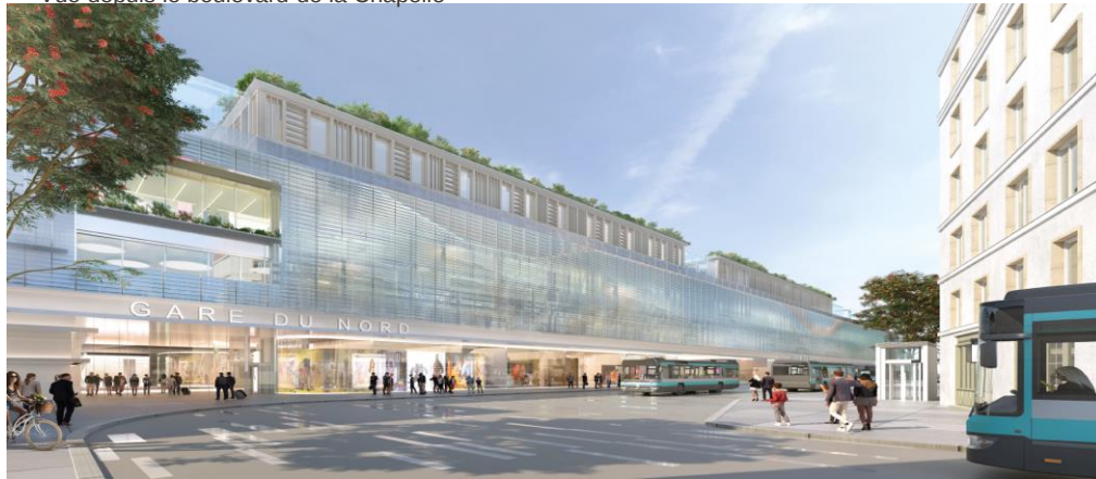
Vue de la gare routière depuis l'accès sortie rue du Faubourg Saint-Denis
