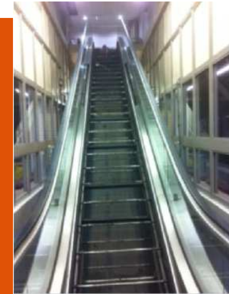
Rénovation de deux escaliers mécaniques Gare de Rouen
