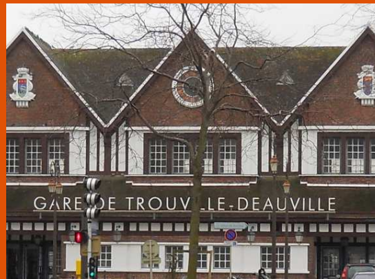
Remplacement de l'horloge double face Gare de Trouville-Deauville
