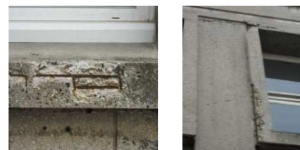
Dégradations béton
