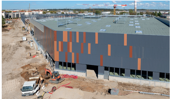
VÉNISSIEUX INDUSTRIAL MAINTENANCE DEPOT
