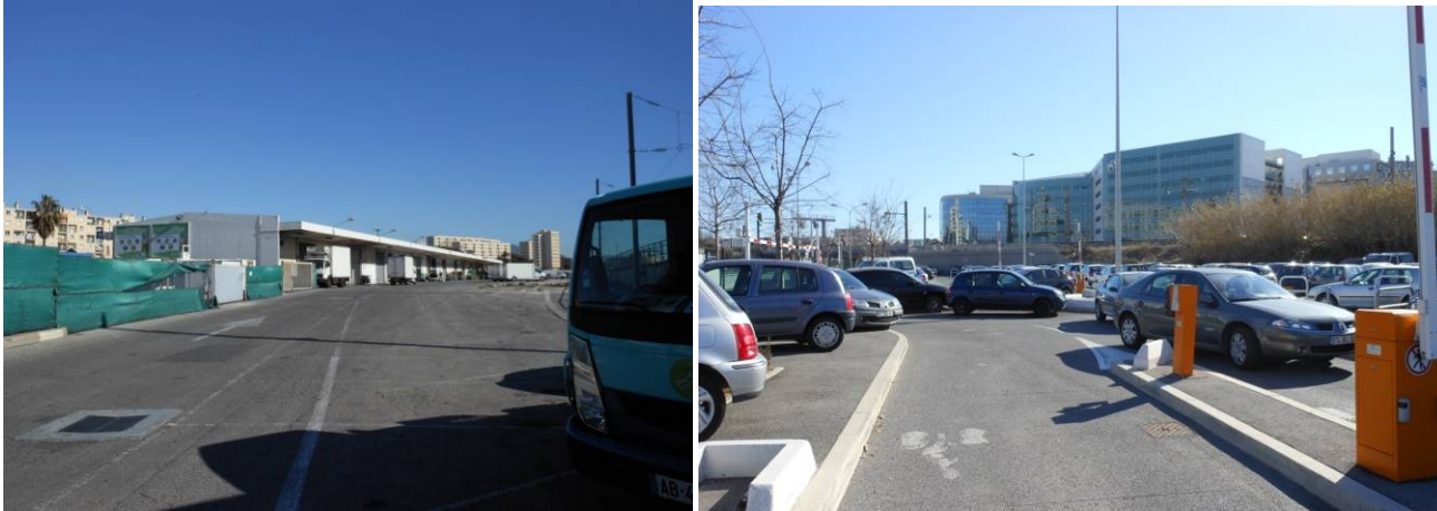
Photographie 11 - Usages antérieurs du site (installations du MIN à gauche et parking Parcazur à droite) (© EGIS, 2012)
