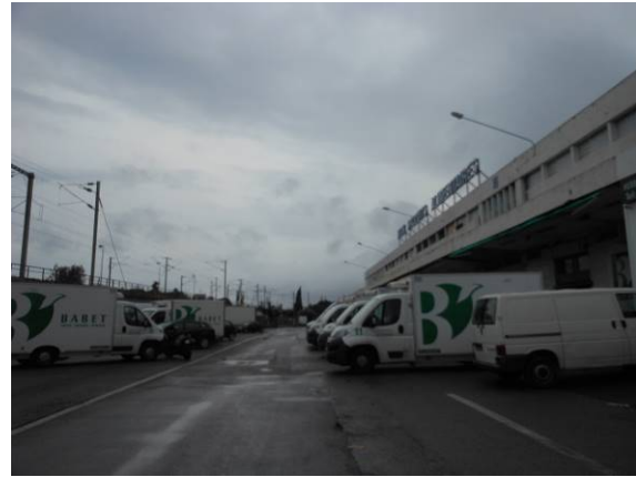
Photographie 2 - Bâtiments et voies internes au MIN (© EGIS, 2016)
