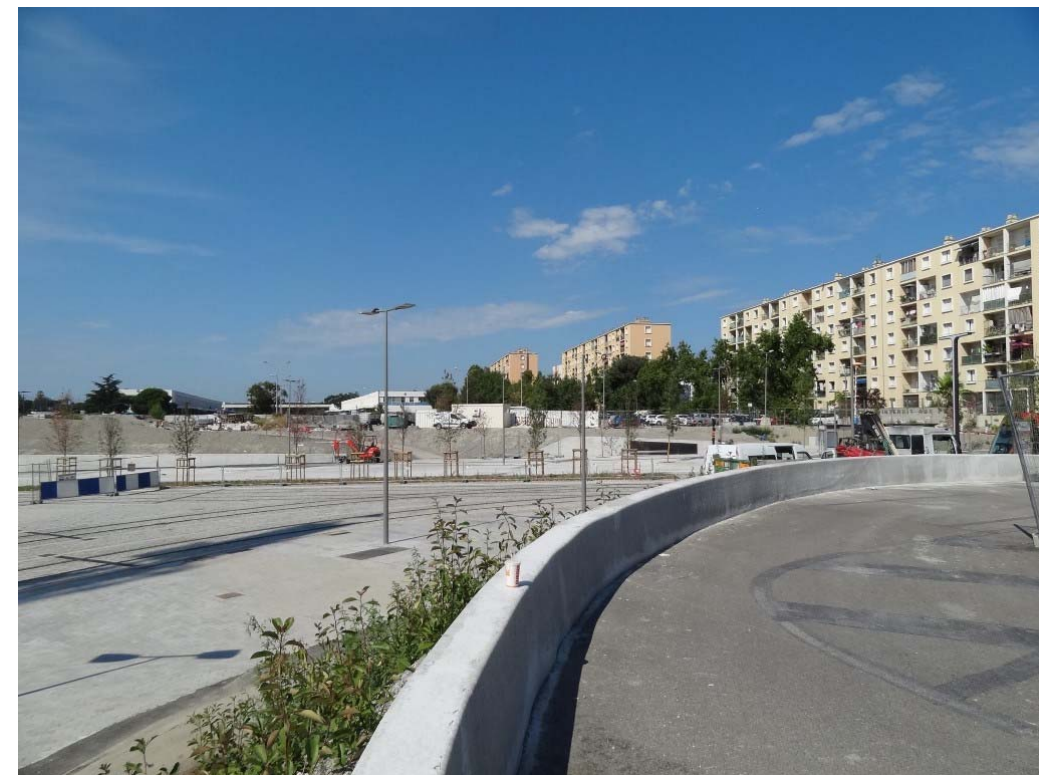
Photographie 41 - Espaces publics du Pôle d'Echanges Multimodal en cours d'aménagement
