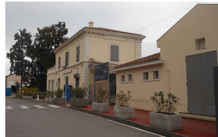
Photographie 35- Gare SNCF Nice Saint-Augustin (© EGIS, 2016)
