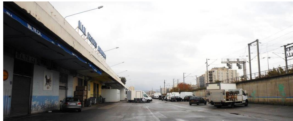
Photographie 38 - Entrepôts, voies de circulation et places de stationnement (© EGIS, 2016)
