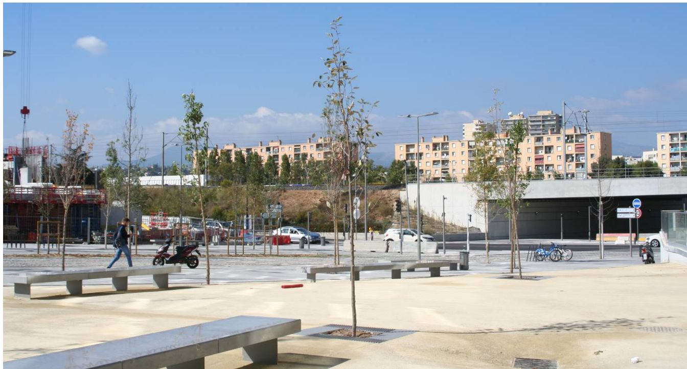
Photographie 20 - Vue du talus ferroviaire (© Parvis-SNCF, 2018)
