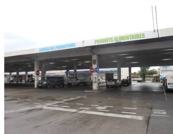
Photographie 3 - Carreaux du MIN (© EGIS, 2016)
