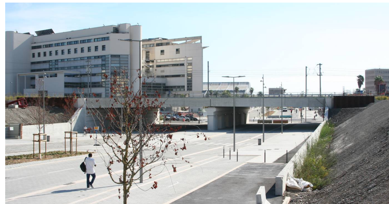
Photographie 26 – Aménagements en cours sur l'axe nord-sud (© Parvis-SNCF, 2018)
