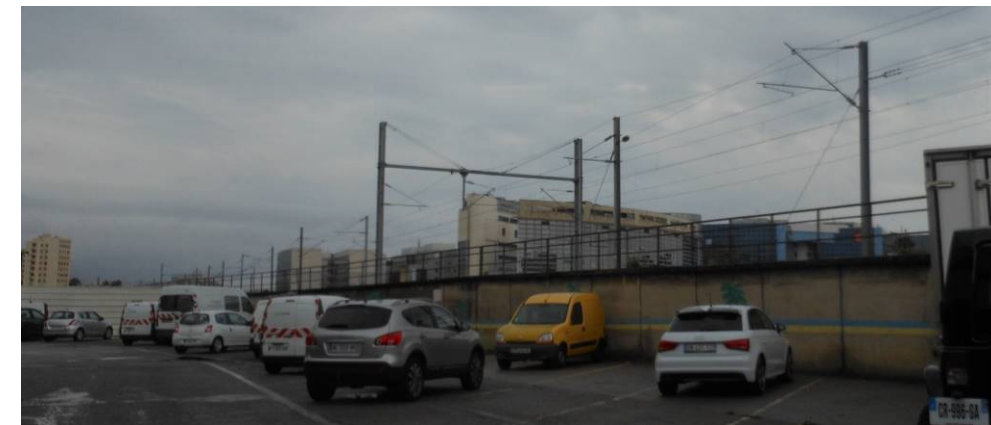
Photographie 36 - Vue du talus ferroviaire depuis le MIN (@ EGIS, 2016)
