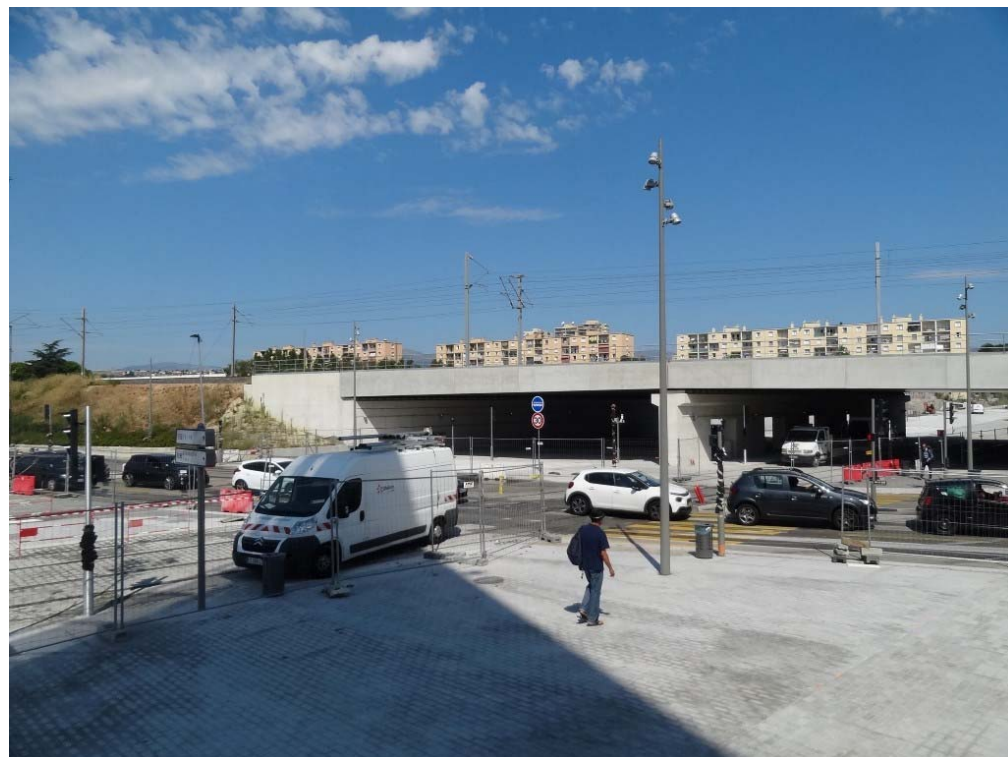
Photographie 42 - Vue de l'ouverture sous le talus ferroviaire depuis le boulevard Cassin (© EGIS, 2018)
