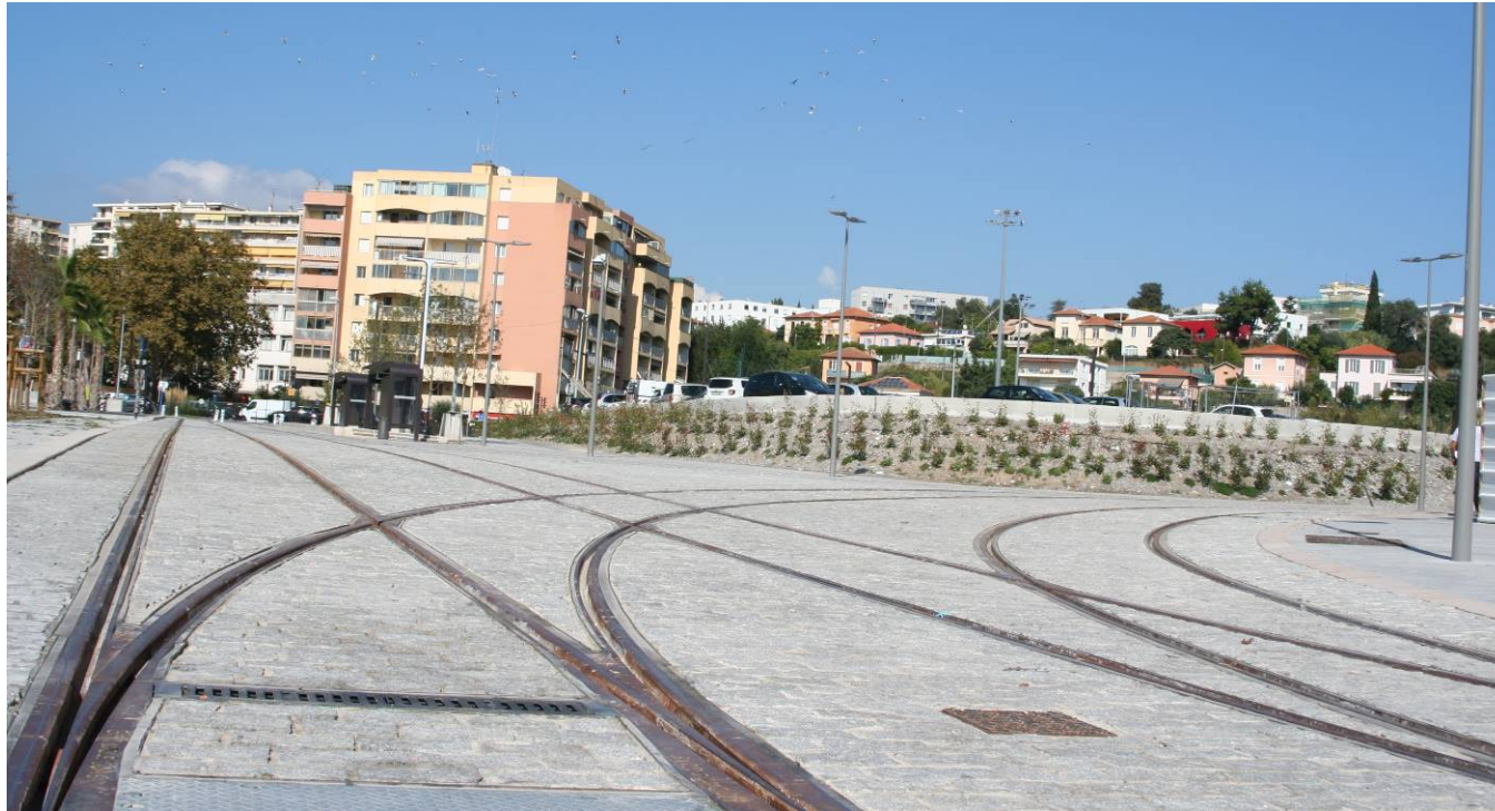
Photographie 27 - Travaux d'aménagement de la ligne Est-Ouest en cours - jonction entre la branche Sud et la branche Nord au niveau de Saint-Augustin (© EGIS, 2017)
